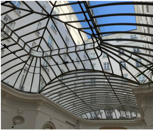
La cúpula de vidre del nou hotel Ritz de Madrid, dissenyada i construïda per l'empresa garrotxina BELLAPART.
