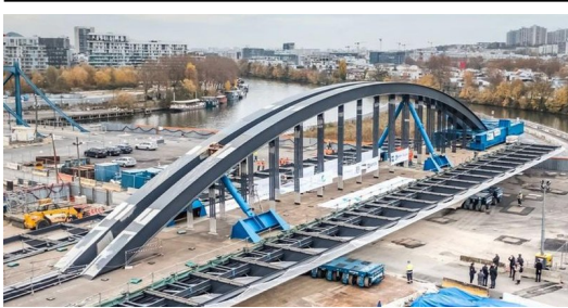
Instal·lació de l'arc lligat de l'estructura, que es va dur a terme divendres passat RCR.
