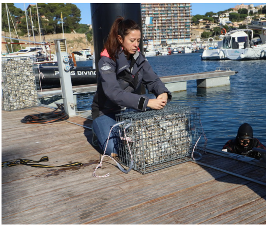
Un dels gabions de recer per als alevins de peixos, ahir al migdia, a punt de ser instal·lat sota un dels pantalans E.A.
