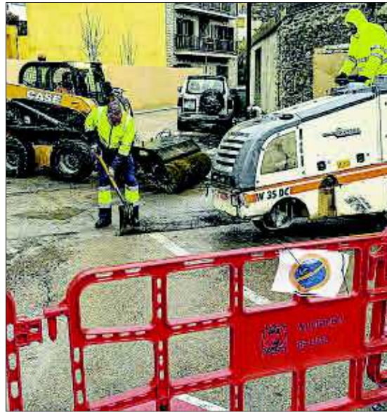
Un operari posa asfalt al carrer
