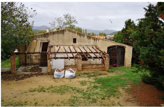
Un dels porxos que s'enderrocaran al mas Oliver, en el marc dels primers treballs de neteja i integració a l'entorn J.T.
