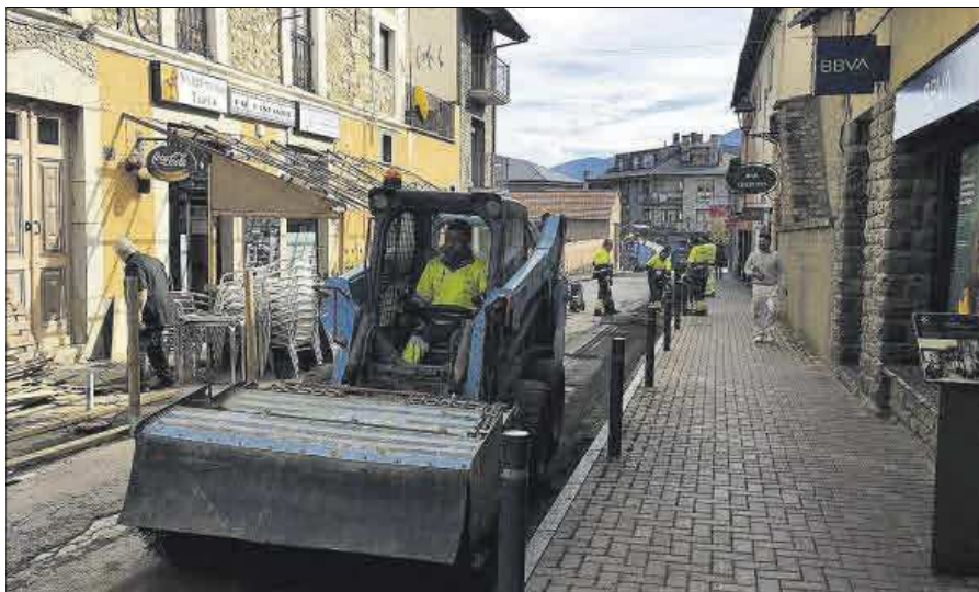
Les màquines treballant en la renovació dels carrers de Bellver aquesta setmana
