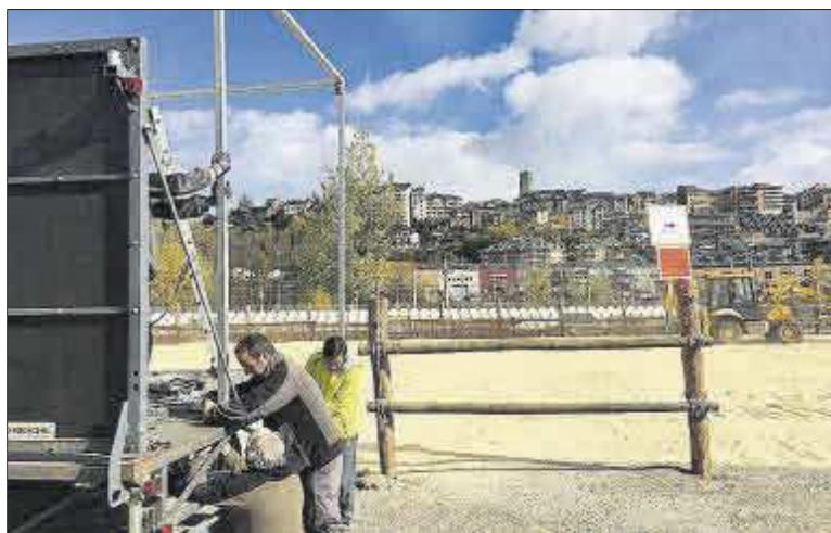
Operaris posen a punt el recinte firal de Puigcerdà
