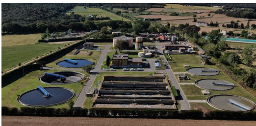
Panoràmica aèria de l'estació depuradora d'aigües residuals de Palamós CACB.
