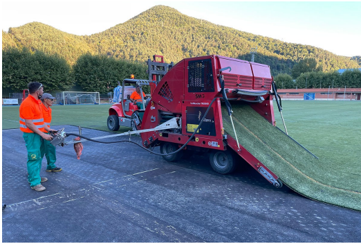
Les obres ja estan en marxa | Ajuntament de Ripoll
