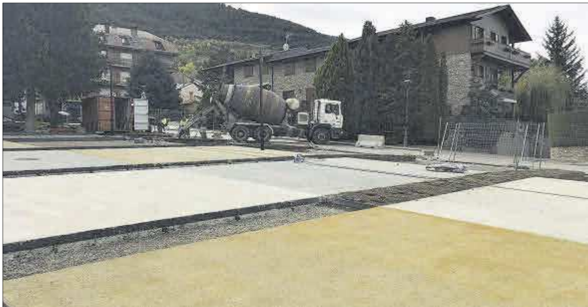
Les obres de remodelació de l'avinguda de la Mancomunitat d'Alp
