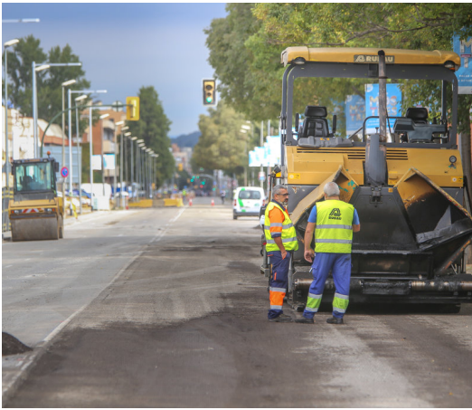
Obres al carrer Barcelona de Girona LLUÍS ROMERO.
