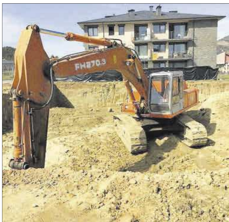
Una grua inicia la construcció d'un edifici a Bellver
