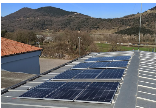
La coberta de l'escola del Pla de Dalt, amb les plaques ja instal·lades. AJUNTAMENT D'OLOI.
