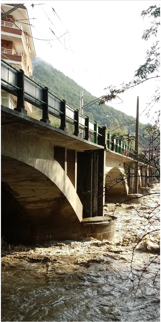
El pont ferroviari de Ripoll dona accés al túnel del passeig Ragull J.C.
