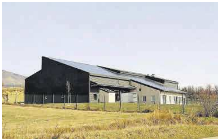
L'edifici de l'escorxador transfronterer d'Ur
