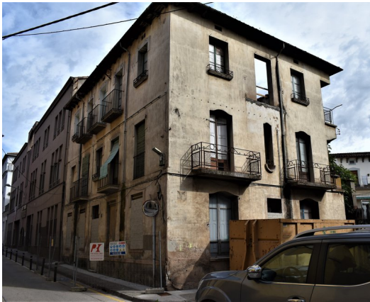
L'edifici, els primers dies de l'enderroc. R.E.
