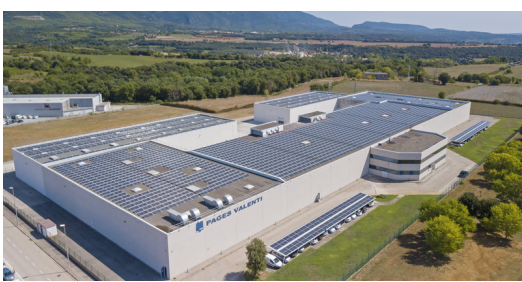
La coberta de la filatura, amb la instal·lació completada. FOTOVOL.
