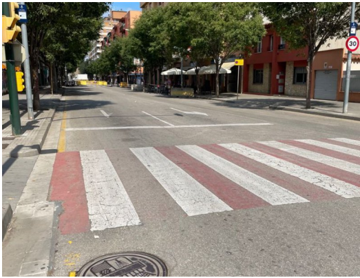
El carrer afectat per les obres EPA.
