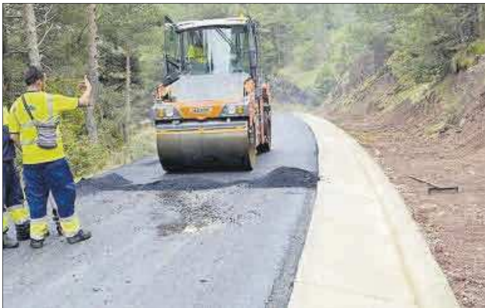
Obres d'arranjament de la via
