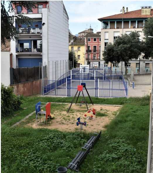
L'àrea d'esbarjo tancada, amb l'espai de jocs per a infants en primer terme i la pista esportiva al fons R.E.
