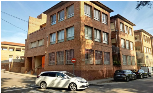
Una vista general de l'edifici de l'antic convent de les monges clarisses, que ha passat a ser municipal J.C.
