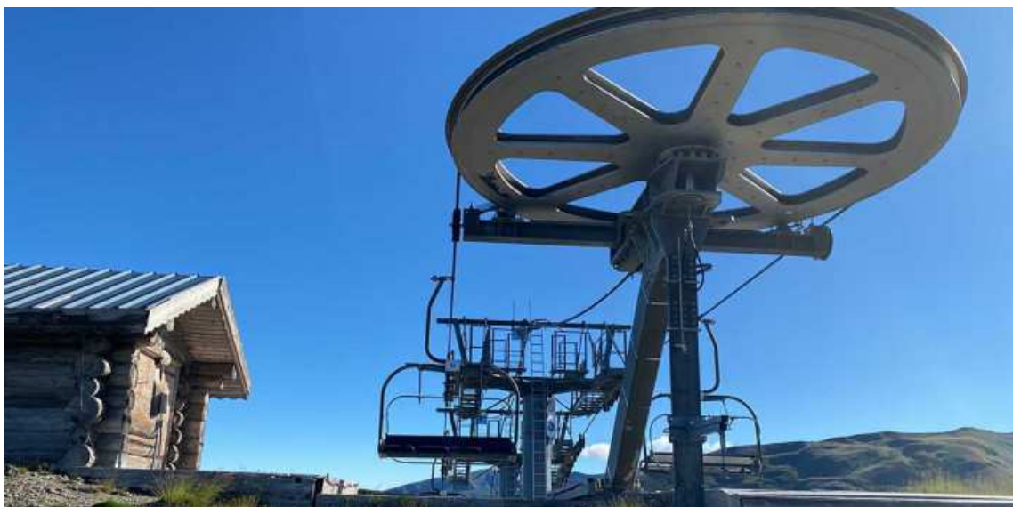
El telecadira Combe des Rameaux, un Poma 4 places de pinça fixa que va ser instal·lat el 2006
