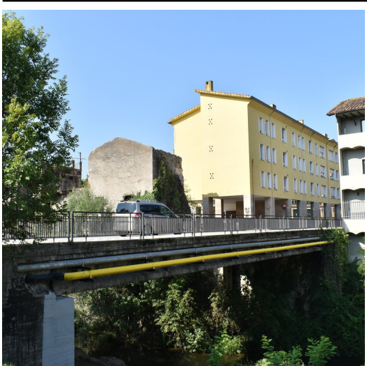
El pont, dissabte passat. En primer terme, l'estrep que ha estat reforçat durant les obres R.E.
