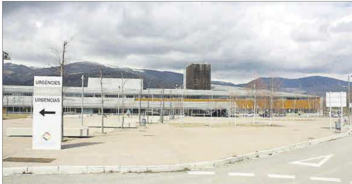
Exterior de l'Hospital de Cerdanya, a Puigcerdà
