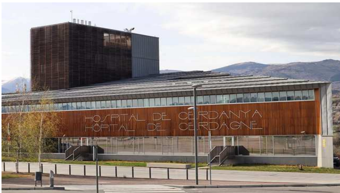
Hospital de Cerdanya / HdC
