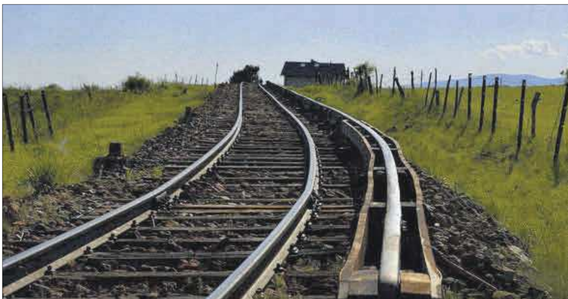
La tercera via del Tren Groc que l'alimenta d'electricitat per poder circular
