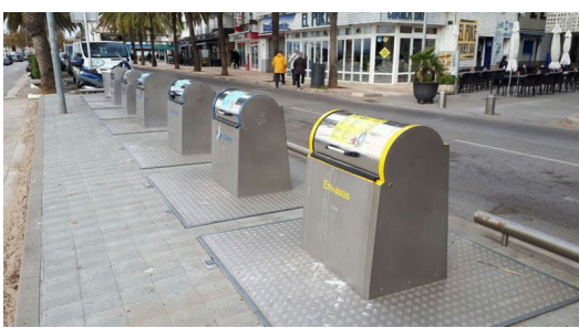
Contenidors d'escombraries subterranis, al nucli urbà de Roses VILA DE ROSES (CEDIDA).
