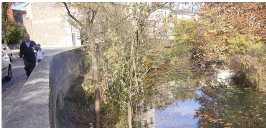
El tram del riu Fluvià al seu pas per la capital garrotxina, entre el pont de cal Russet i el de les Mores J.C.
