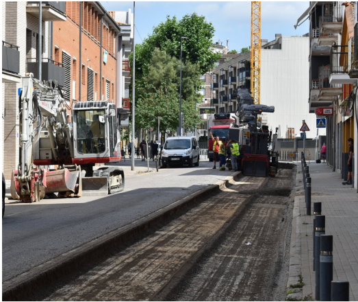
Les màquines a l'inici de les obres en un altre tram del carrer Llibertat, dilluns al migdia R.E.
