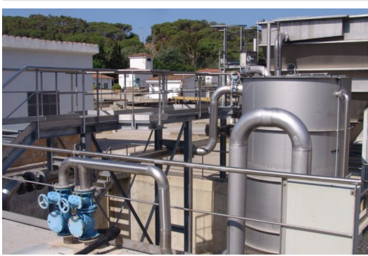
Estació depuradora d'aigües residuals de Tossa (EDAR) ARXIU.
