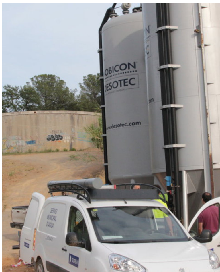
Empleats de l'antiga Sorea, el 2016, instal·lant uns filtres al sistema E. AGULLÓ.
