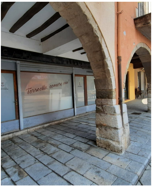
La reforma de Can Castells, on es farà la futura seu de l'Oficina de Turisme de Torroella AJ. TORROELLA DE M.
