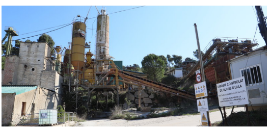
La zona de maquinària de la pedrera del Mas Blanc, que s'hauria de desmantellar E.A.
