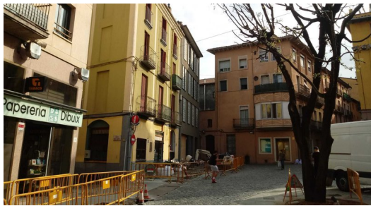
L'antic bar el Carme i les obres de millora dels serveis de la plaça J.C.
