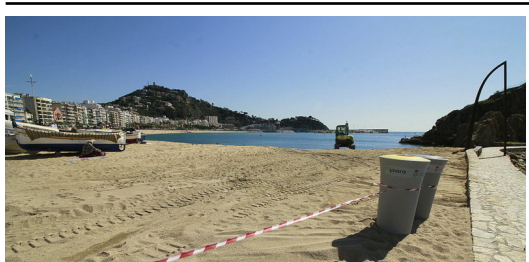
Operaris, en uns treballs d'aplanament de la platja de s'Abanell de Blanes, fa deu dies AJUNTAMENT DE BLANES.
