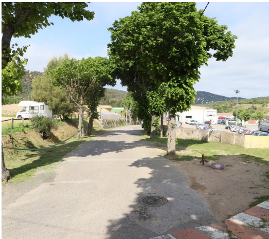
La ronda Narcís Massanas, reurbanitzada, farà funcions de tram final de la carretera GI-682 cap a Tossa E.A.
