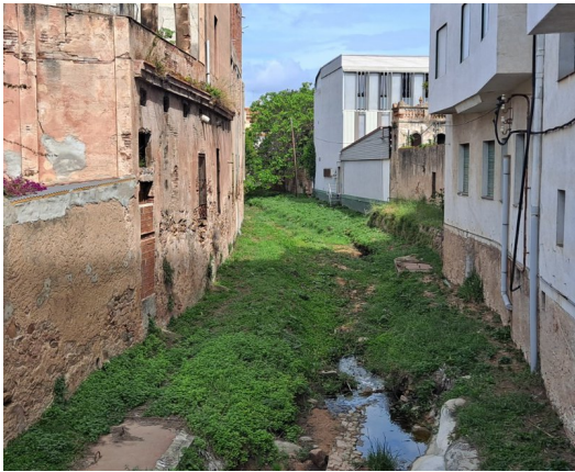
El primer tram que es cobrirà de la riera, annex als jutjats AJ. SFG.
