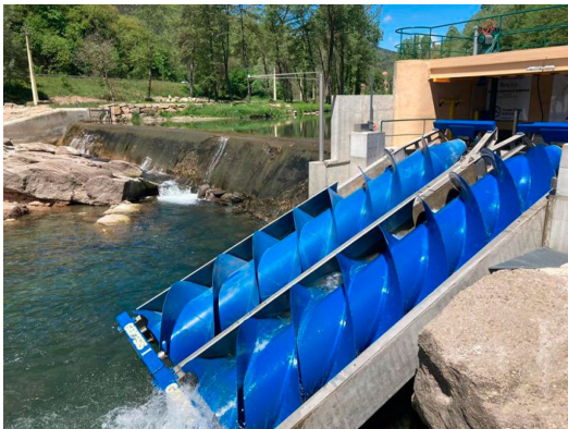
El primer cargol d'Arquímedes de Catalunya s'ha posat a la depurador de la Corba de Ripoll | ACN
