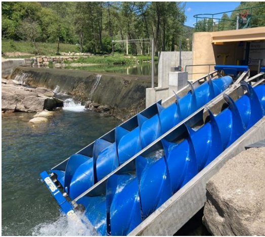
Vista general de les espirals instal·lades a Ripoll EPA.
