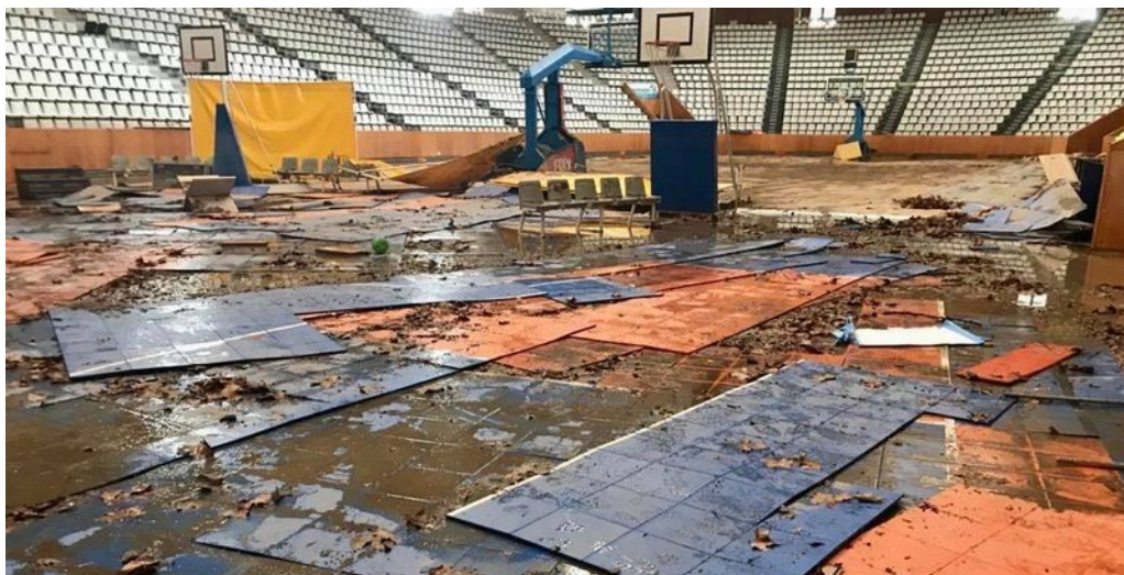
El pavelló de Fontajau amb el parquet totalment aixecat. GISELA PLADEVAYA.
