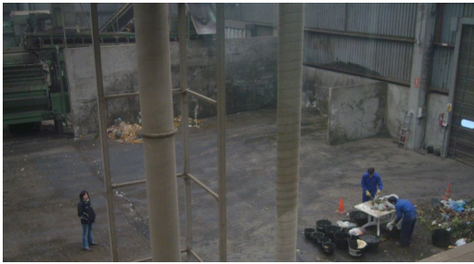
Una vista interior de les instal·lacions de la planta de compostatge de la Garrotxa J.C.
