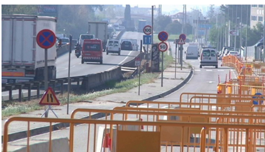
Obres del tercer carril de la C-17 en sentit sud | VOTV
