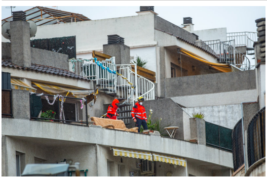
Els Bombers van inspeccionar el balcó de l'àtic on va esclatar la bombona ahir al matí QUIM PUIG.
