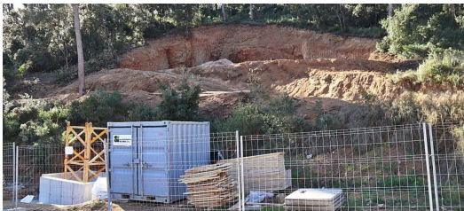
Les obres per construir una casa al sector de Montcal (Begur), el passat mes de desembre.
