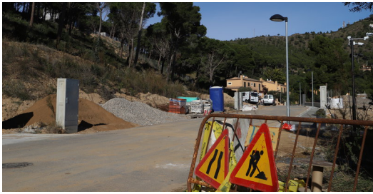
Obres al sector Montcal de Begur E.A.
