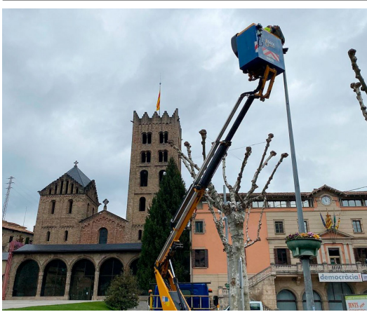
Uns operaris, substituint les actuals lluminàries | Ajuntament de Ripoll
