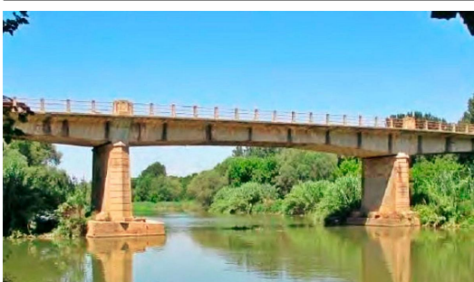
Pla obert del pont de la C-252 sobre el riu Ter a Verges en una imatge d'arxiu.
