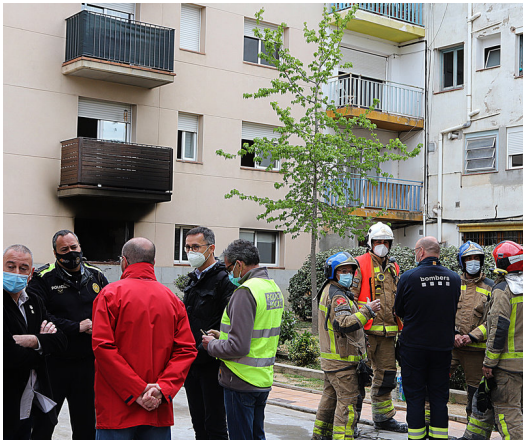
Autoritats i bombers, divendres, després de l'incendi que va tenir lloc en un habitatge ocupat MANEL LLADÓ.
