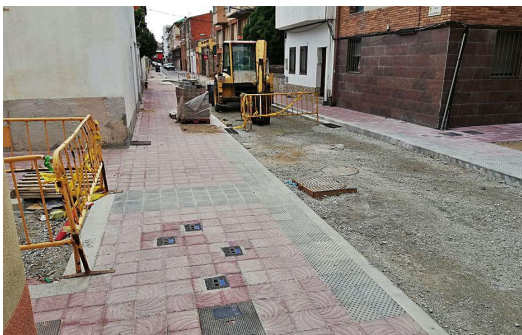
Un dels carrers afectats amb el seu estat actual d'obres.
