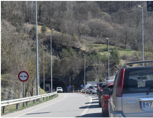
El túnel de Collabós, en el límit de les comarques del Ripollès i la Garrotxa R.E.
